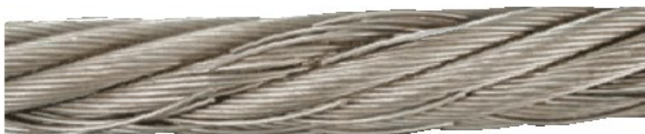
Rys. 2. Duża liczba zerwanych drutów, świadcząca o poważnym zużyciu liny przeciwwzitej – uzasadnienie natychmiastowej wymiany.
