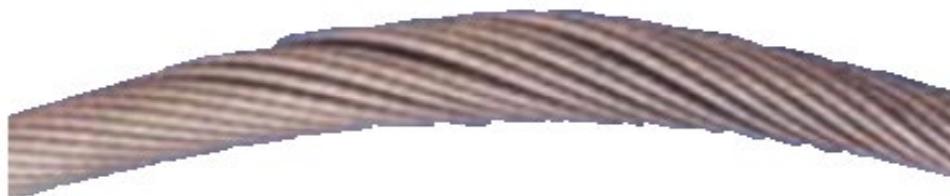
Rys. 11. Wyciśnięcie drutów w jednej splotce; badania całej liny może pokazać, że zniekształcenie jest widoczne w regularnych odstępach, normalnie w jednej splotce.
